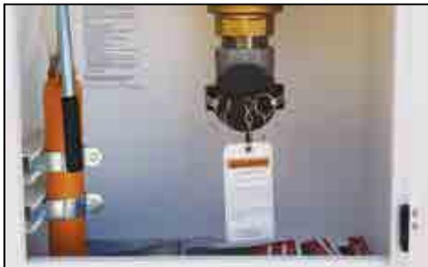
Fig 4 - Remote fill cap warning tag
